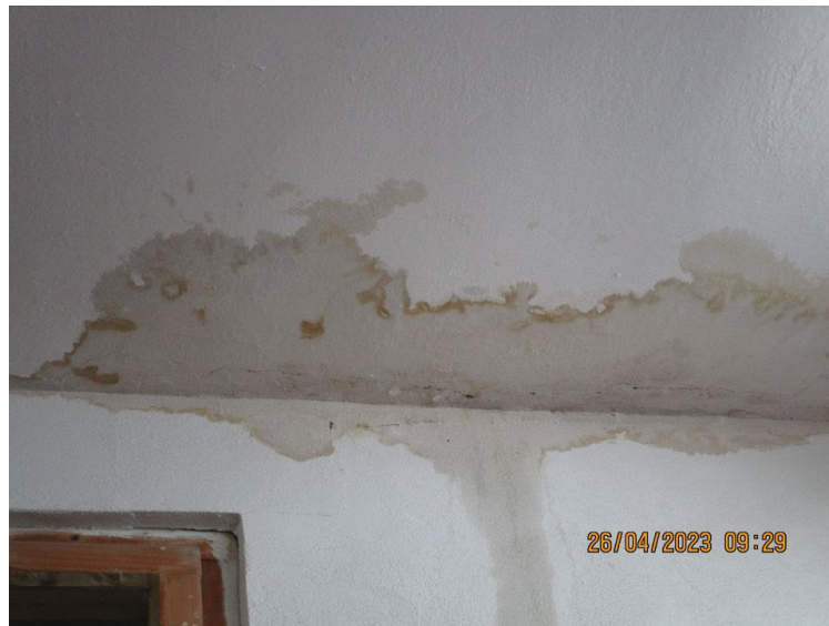
Obr. č.3 – ÚK 26.04.2023- na predajnej ploche na 5 miestach v častiach nad chladiacou vitrínou s uskladnenými mliečnymi výrobkami, nad regálmi s nealkoholickými nápojmi, konzervami, cestovinami, čokoládou a cukrovinkami zamoknutý a zaplesnivý strop
