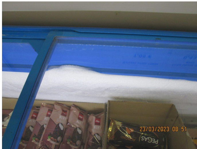
Obr. č.10 – ÚK 23.03.2023 - Výskyt hrubej vrstvy námrazy, hrúbka cca 5 cm vnútornej časti mraziaceho zariadenia na predajnej ploche určeného na uskladnenie mrazených krémov.
