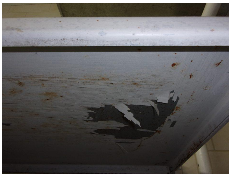
Obr. č.2 – ÚK 08.03.2023 - Poškodený, olupujúci sa hygienický náter regálu v chladiacom boxe surovín.
